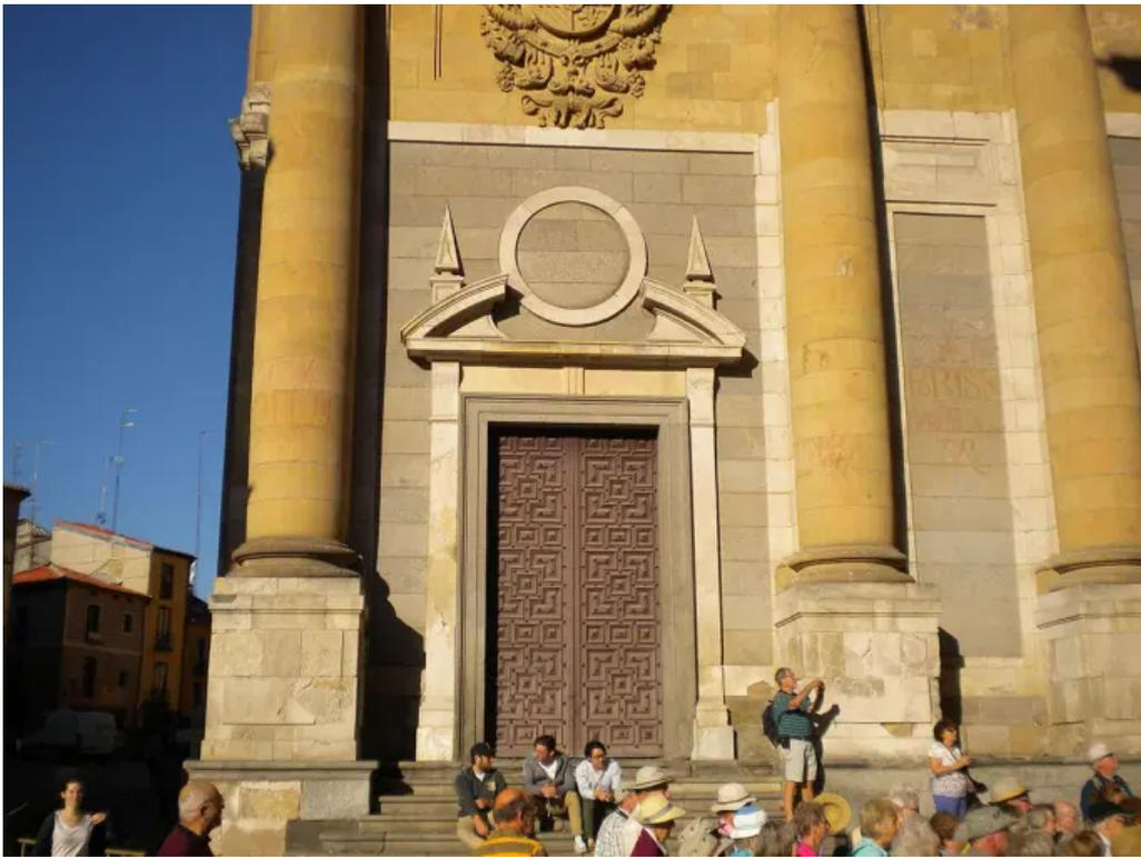
*Imagen de la fachada principal de la Clerecía, en la que se pueden ver tres de los cuatro tipos de piedras empleados en su construcción: la Piedra Franca con color amarillo, el granito de Los Santos de color gris claro y la vaugnerita de color gris oscuro (imagen propia).*
